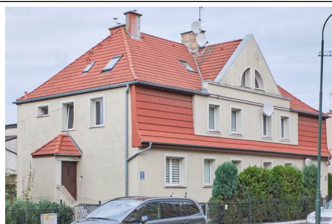
Widok ogólny bryły od strony południowo-zachodniej
