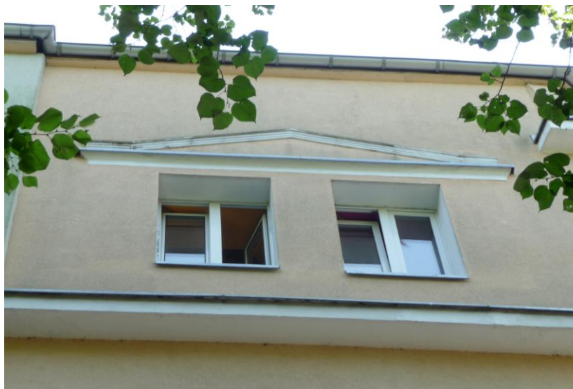
Otwory okienne w elewacji północnej
