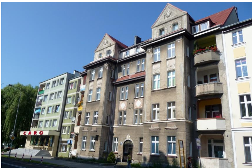
Widok budynku od południowego-zachodu
