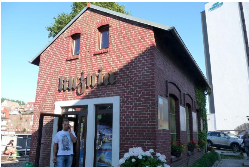
Widok budynku od północnego-zachodu
