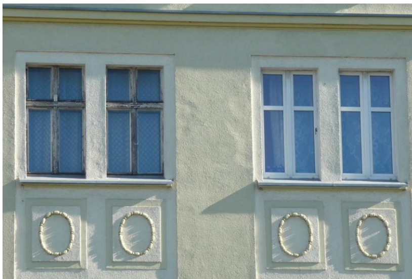
Otwory okienne elewacji północnej
