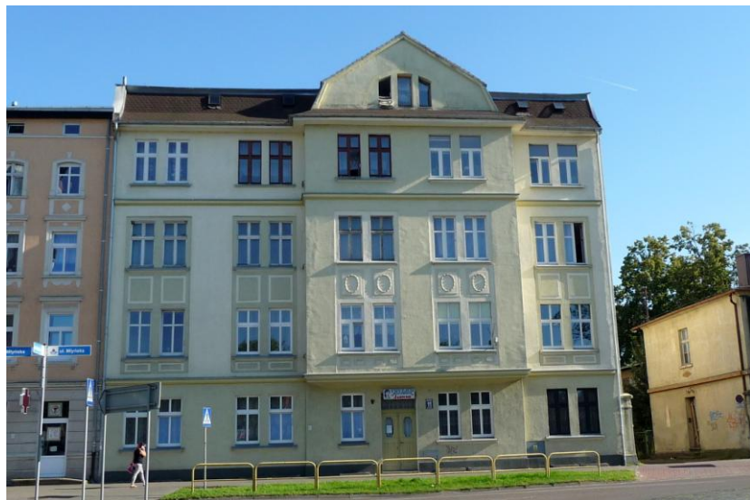
Widok budynku od północy
