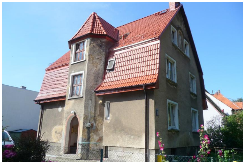
Widok budynku od północnego-wschodu
