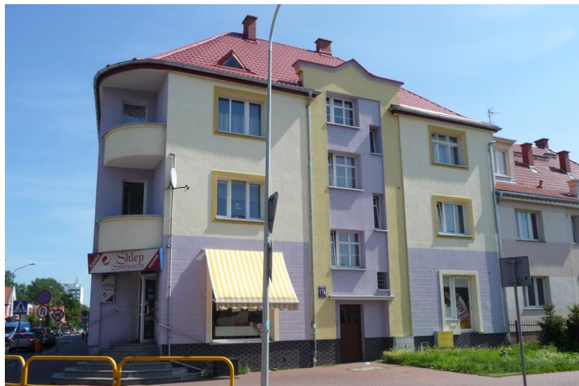
Widok budynku od południowego-zachodu
