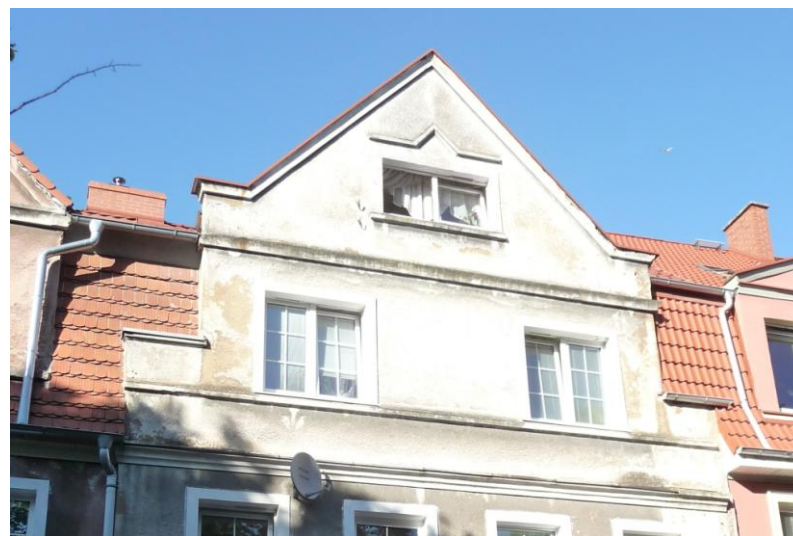
Facjata w frontowej połaci dachu
