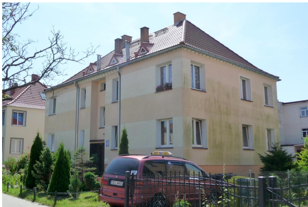
Widok budynku od północy
