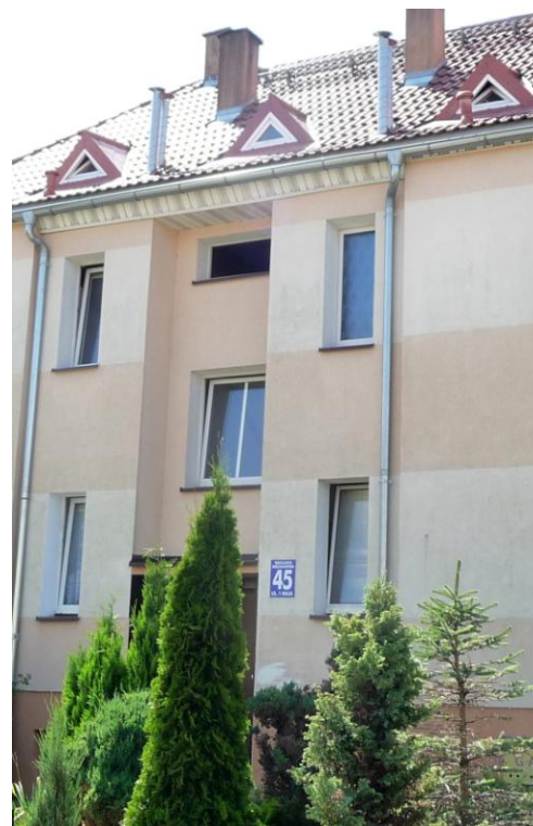
Część elewacji północno-wschodniej
