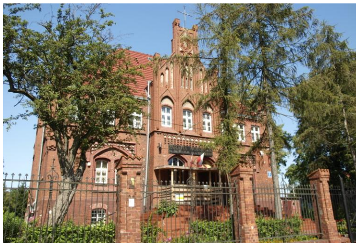
Widok budynku od południowego-zachodu
