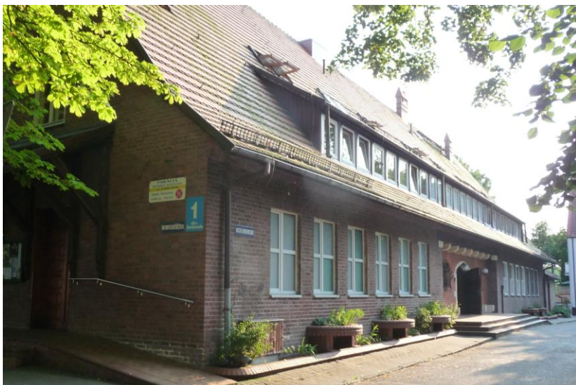
Widok budynku od północnego-wschodu
