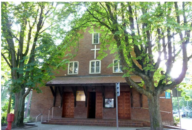
Widok budynku od wschodu
