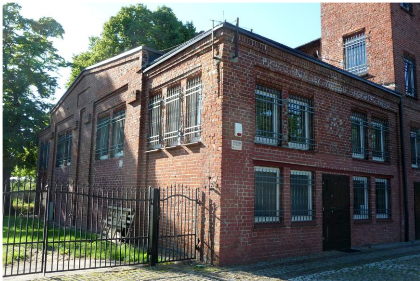
Widok budynku od południowego-wschodu
