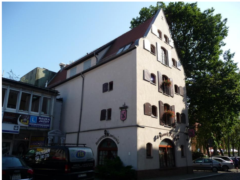
Widok budynku od północy
