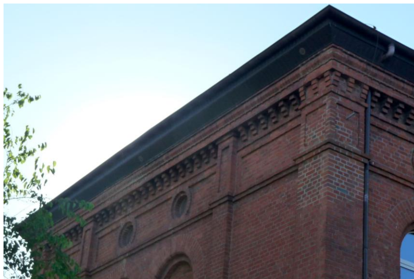
Fragment południowo-wschodniego narożnika budynku
