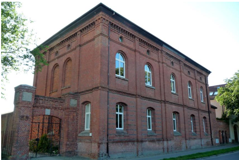
Widok budynku od wschodu
