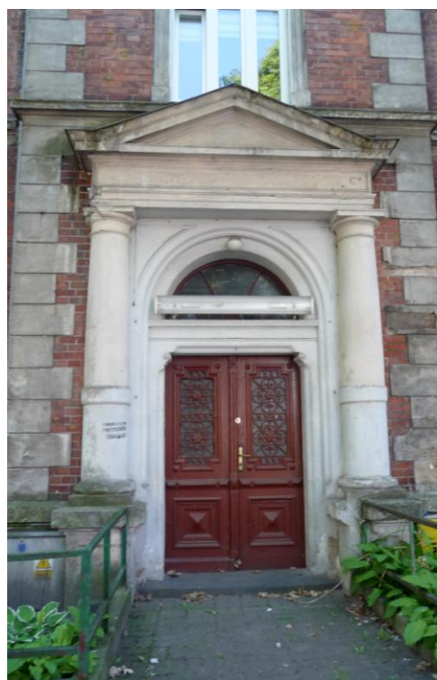
Portal drzwiowy w elewacji wschodniej
