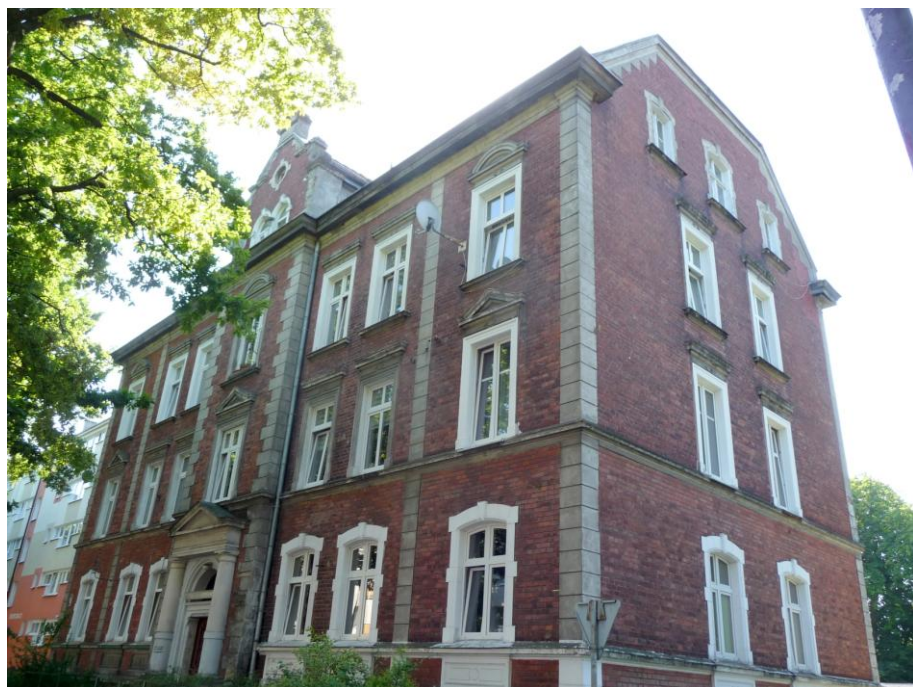
Widok budynku od północnego-wschodu
