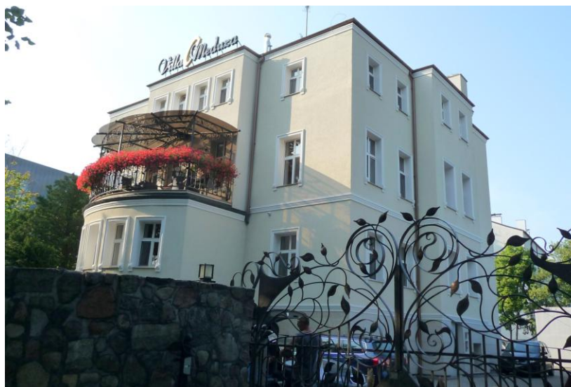
Widok budynku od południowego-wschodu
