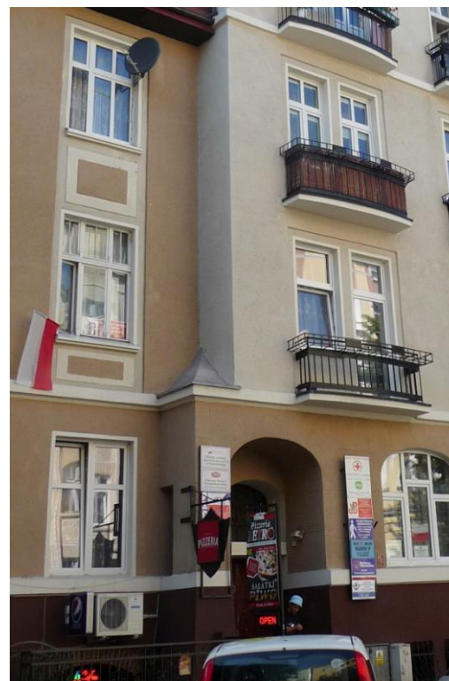
Ryzalit elewacji południowo-wschodniej
